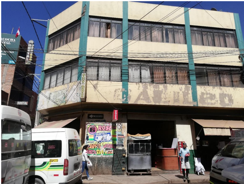
Fotografía N° 16: Irregularidades estructurales encontradas.
