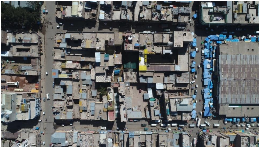
Fotografía N° 24: Vistas aéreas tomadas con el drone – Mercado Santa Bárbara
