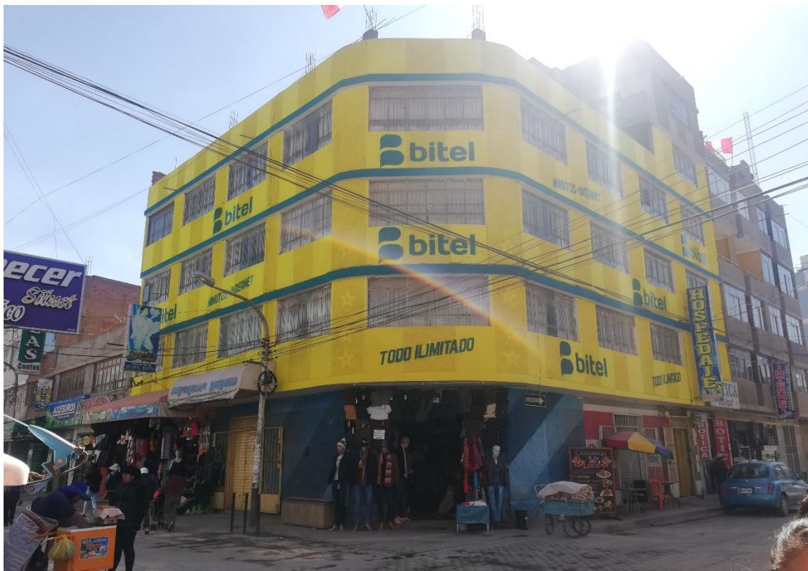
Fotografía N° 12: Irregularidades estructurales encontradas.
