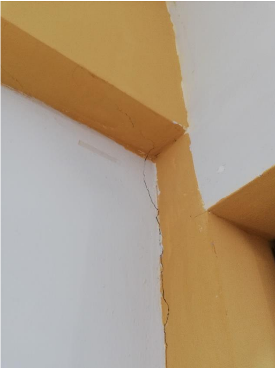
Fotografía N° 26: Muros y losas con fallas estructurales
