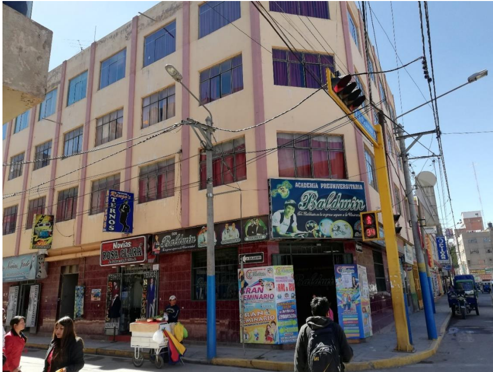
Fotografía N° 19: Irregularidades estructurales encontradas.
