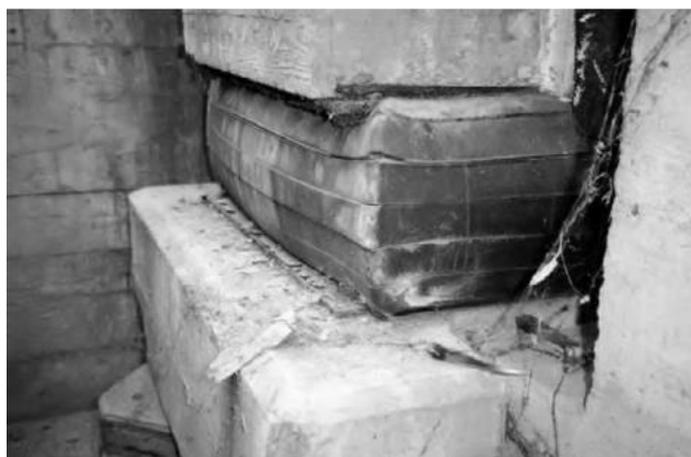
*Figura 2.10.* Aisladores de caucho usados en la escuela Pestalozzi.
